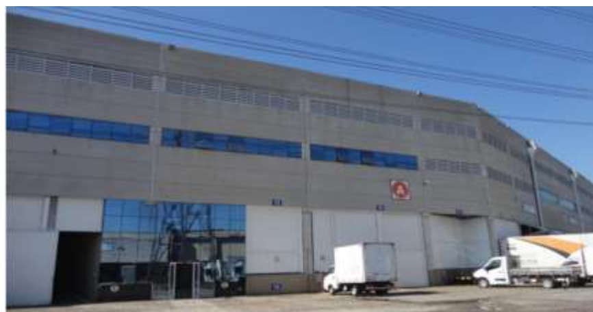
Foto do Galpão
