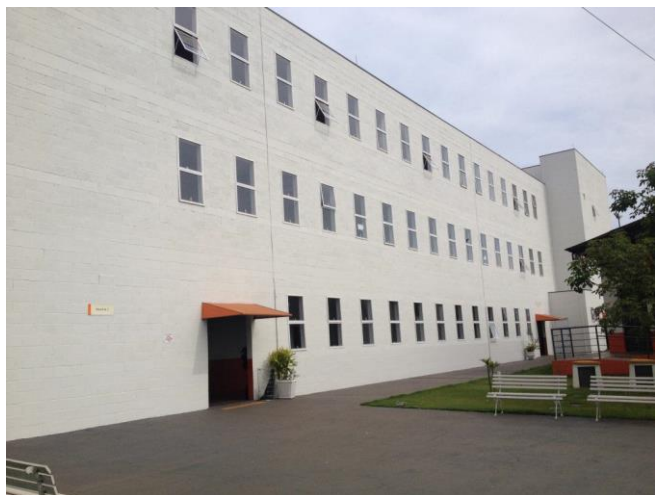
Bloco C – Fachada
