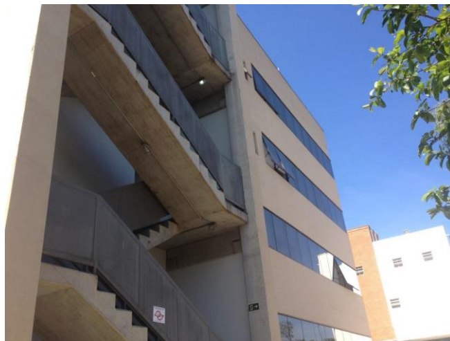
Fachada do Bloco Administrativo 02 – escada de emergência
