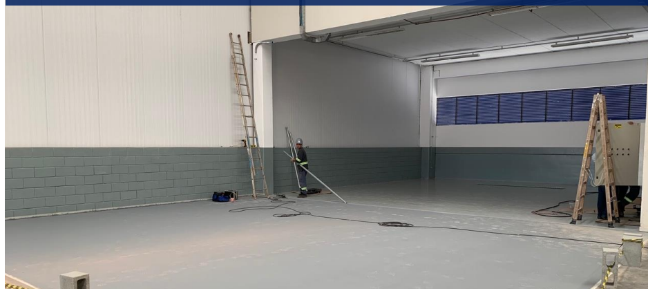
Salas de baterias
