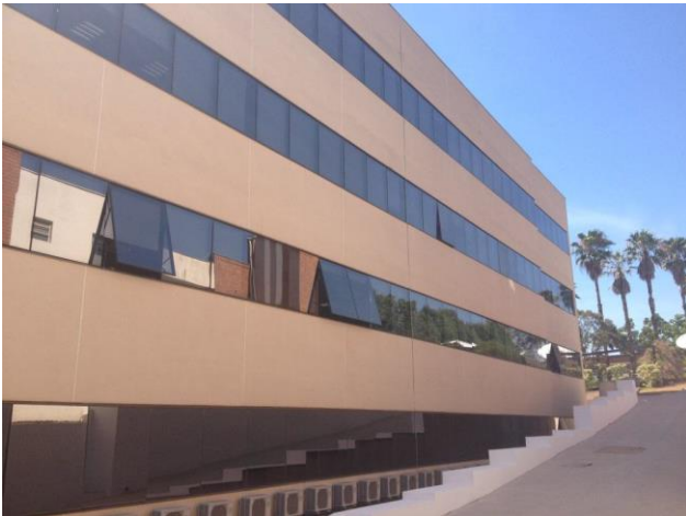
Bloco Administrativo 02 – fachada lateral
