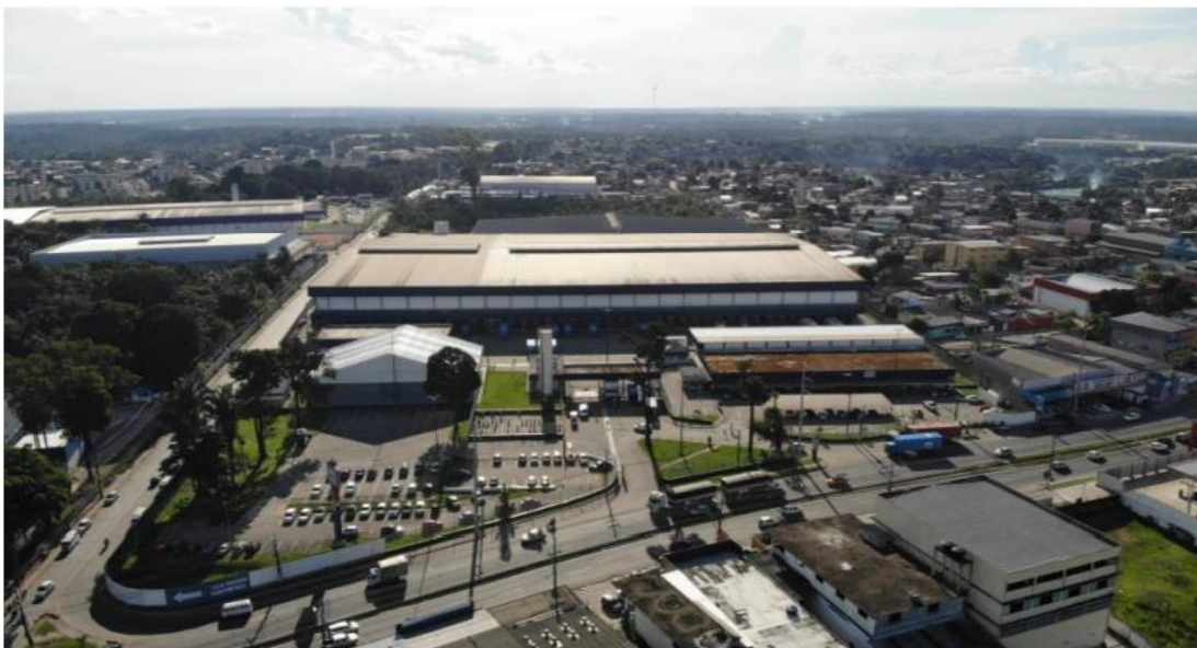
Imagem Aérea SLB Bemol em operação em Manaus. Fonte: Grupo HSI.
