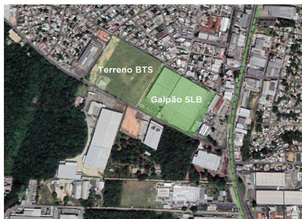
Localização Terreno e Planta BTS e Galpão SLB Bemol. Fonte: Google Earth e Grupo HSI.
