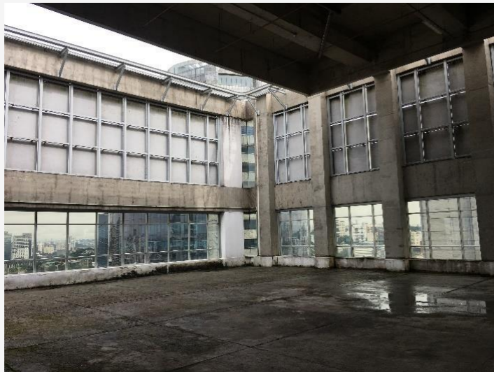
2019 | Cobertura com acúmulo de limo no piso e platibanda.
