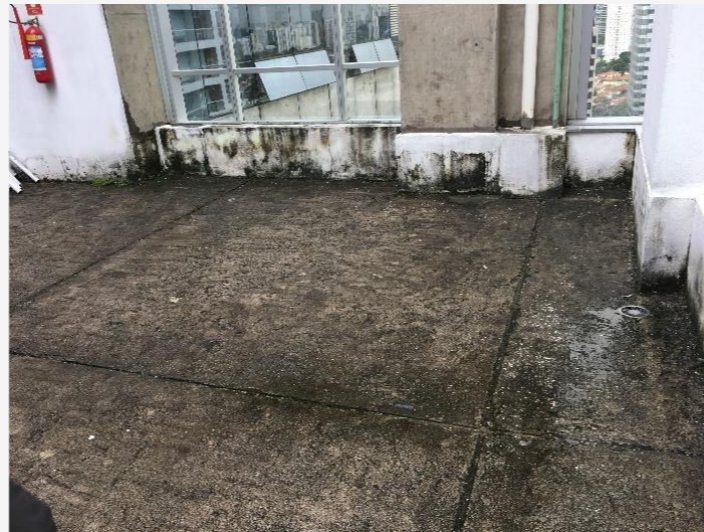
2019 | Cobertura com acúmulo de limo no piso e platibanda.
