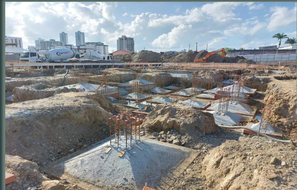
Concretagem de várias sapatas
