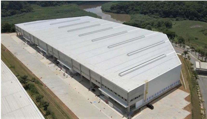
Galpão Expansão SBP
