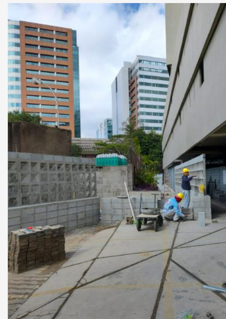
Obra no Ed. Passarelli
