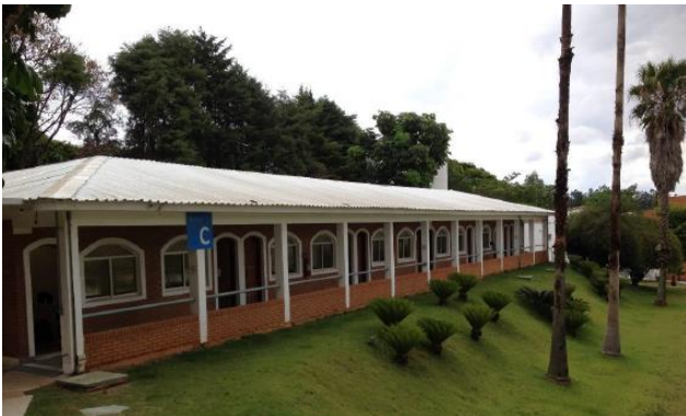
Fachada – Bloco C
