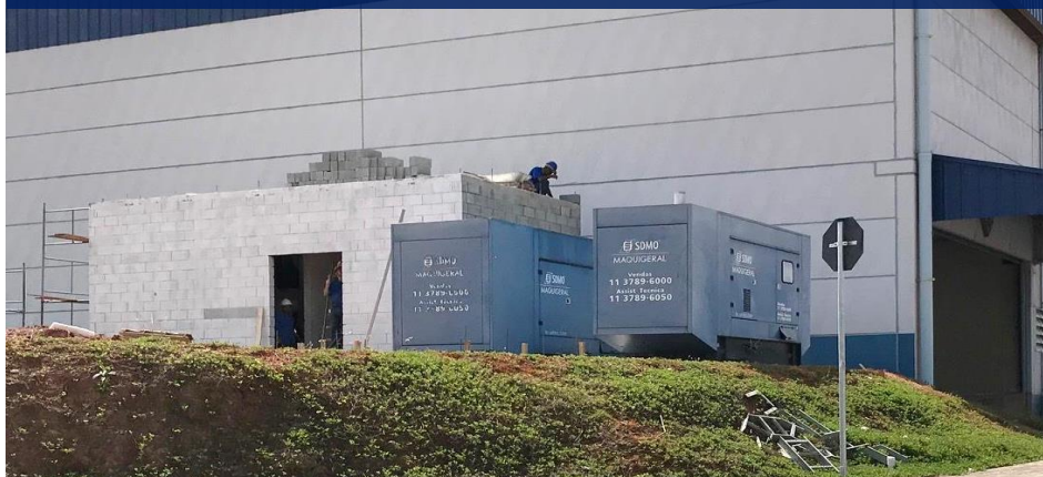
Construção - Entrada de Energia / Geradores
