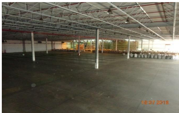
Galpão Interno antes da reforma
