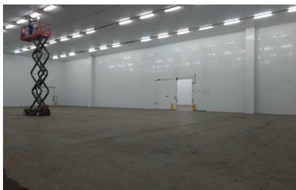
Galpão área climatizada pós reforma
