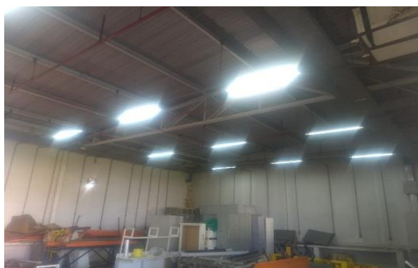
Galpão área Climatizada antes da reforma
