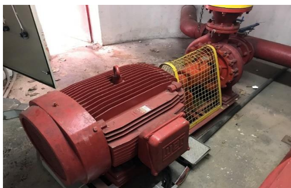
Sala Bomba de Incêndio antes da reforma
