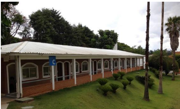
Fachada – Bloco C
