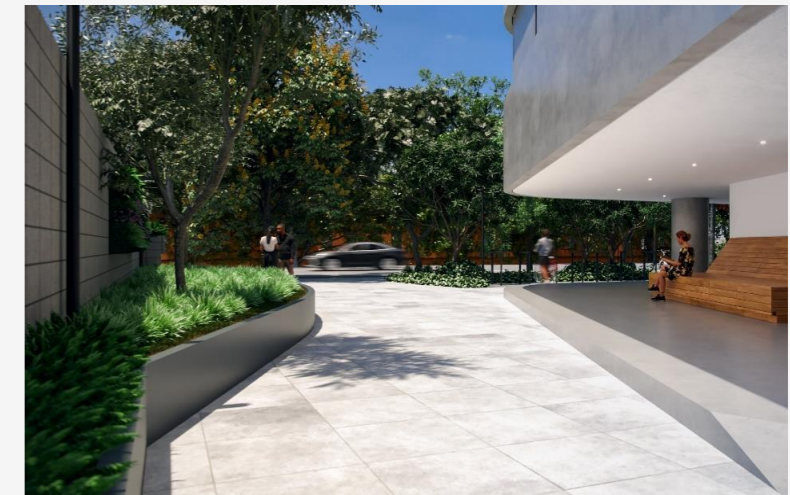
3. Acesso interno do Ed. Passarelli
