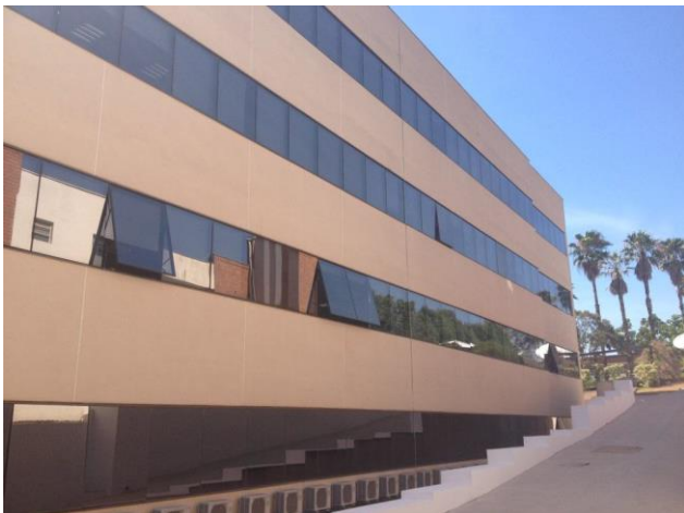
Bloco Administrativo 02 – fachada lateral
