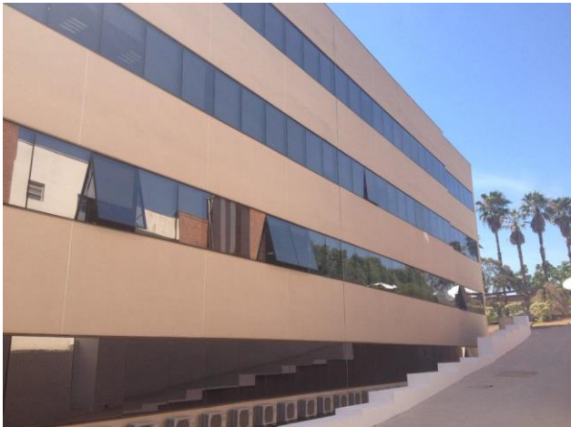
Bloco Administrativo 02 – fachada lateral
