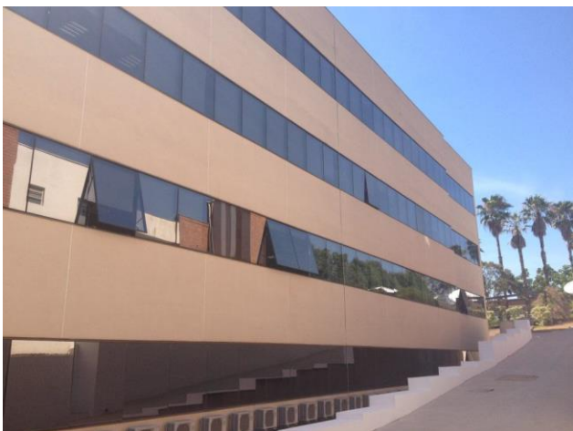
Bloco Administrativo 02 – fachada lateral
