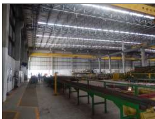
Aspecto interno do galpão 1
