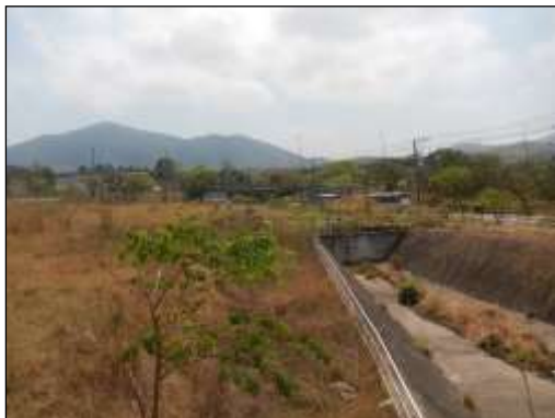
Desnível na porção norte do terreno
