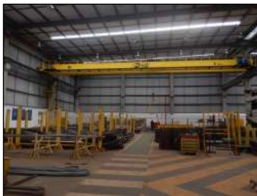
Aspecto interno do galpão 2
