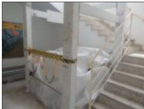
Acessos verticais (escada e vão para elevador)
