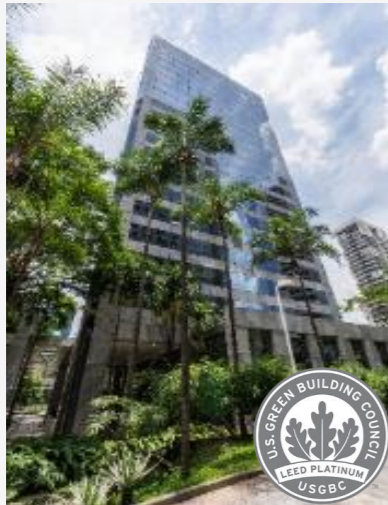
1. Ed. Torre Sul
