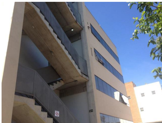
Fachada do Bloco Administrativo 02 – escada de emergência
