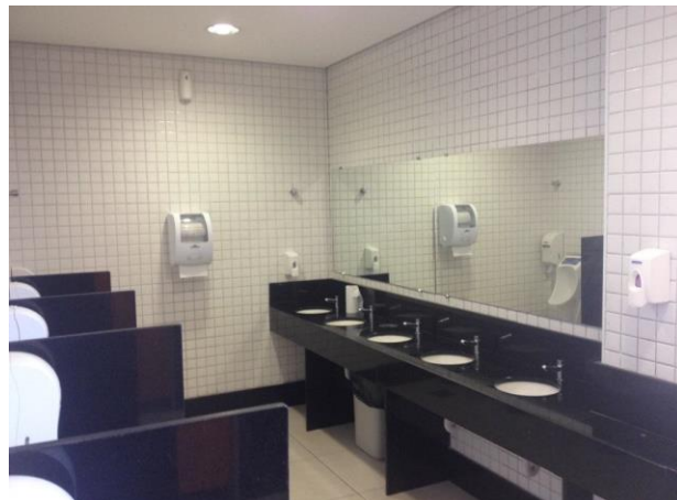
Bloco Administrativo 02 – sanitário
