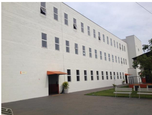
Bloco C – Fachada
