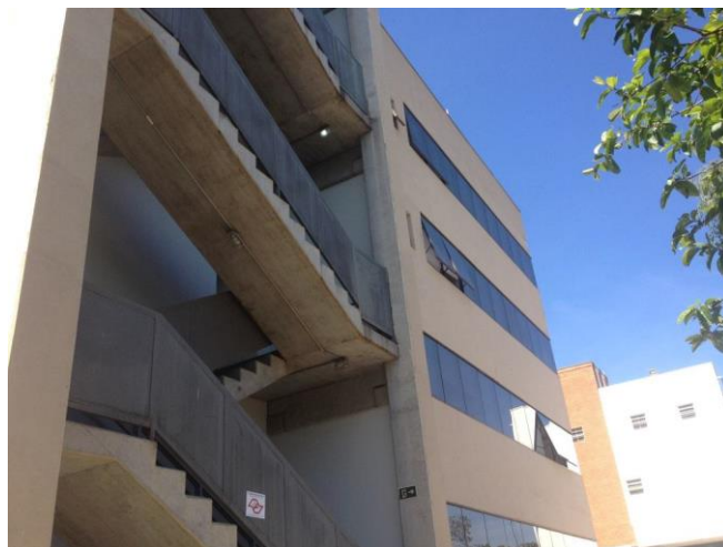
Fachada do Bloco Administrativo 02 – escada de emergência
