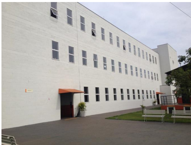
Bloco C – Fachada
