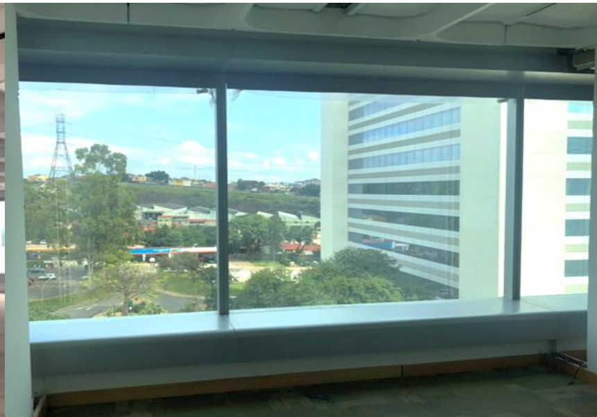
Vista Externa – Andar Tipo
