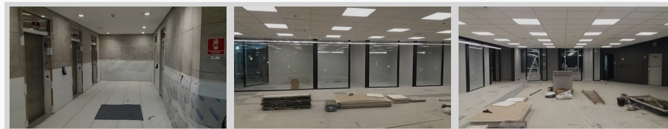
Obras do 8º andar
