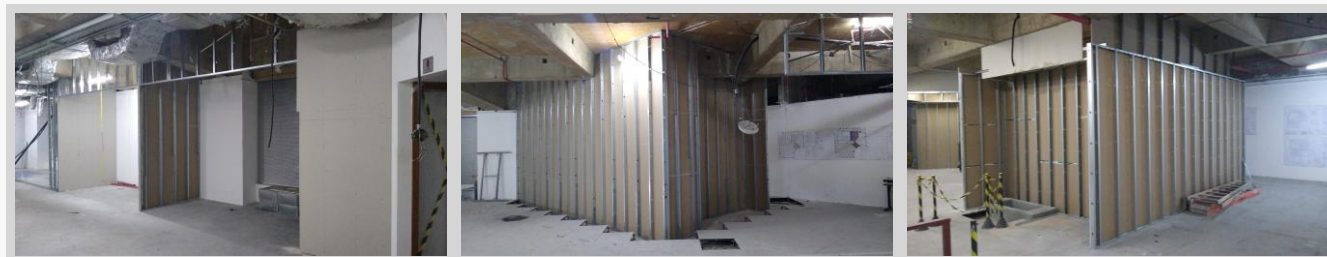
Obras do 11º e 12º andar
