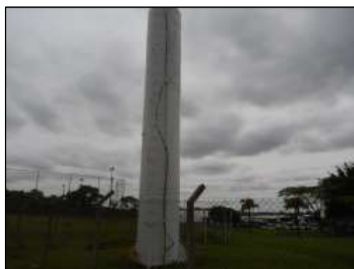
Reservatório de água desativado
