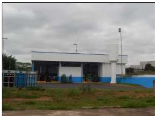
Prédio de manutenção de cilindros
