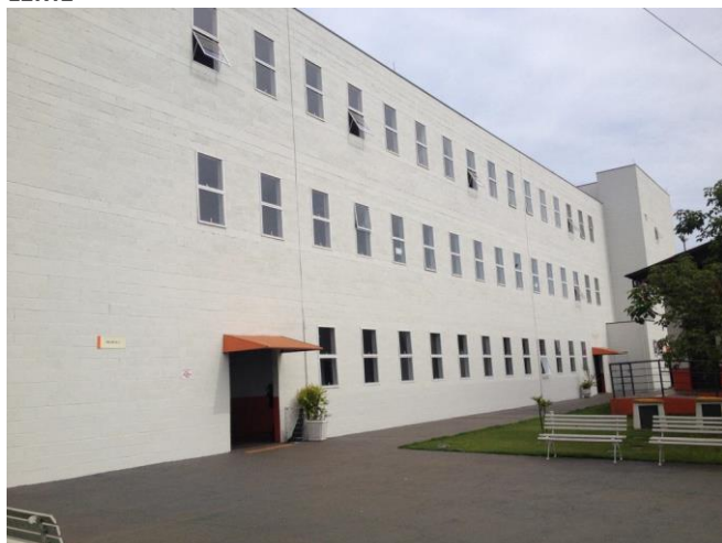
Bloco C – Fachada
