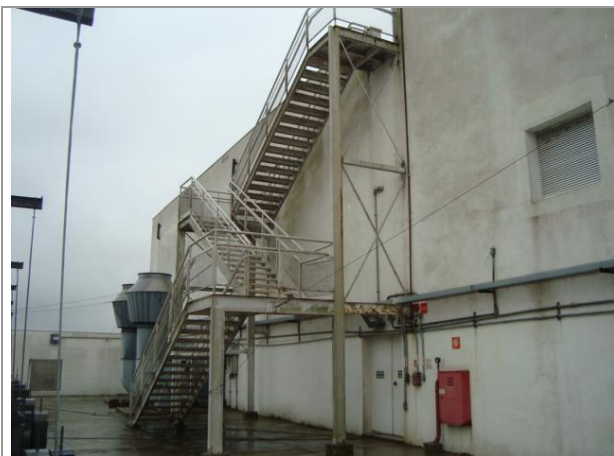
Vista Acesso Heliponto
