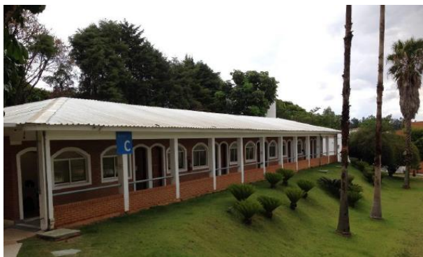
Fachada – Bloco C
