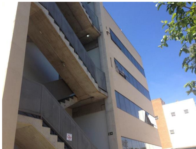
Fachada do Bloco Administrativo 02 – escada de emergência
