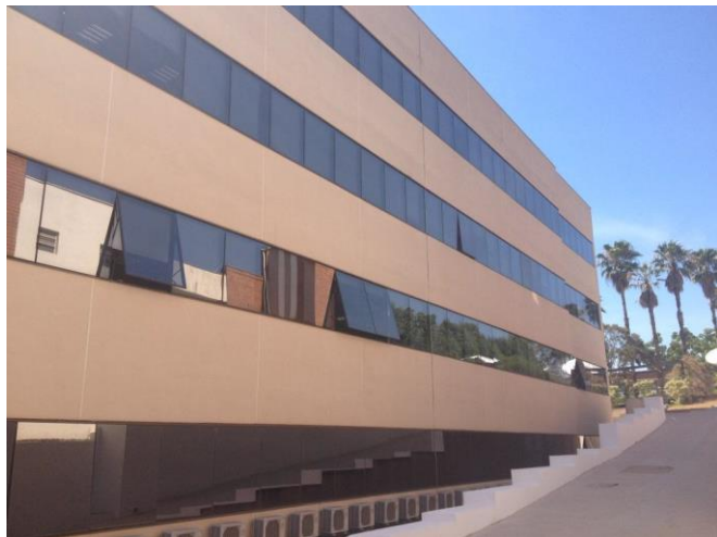
Bloco Administrativo 02 – fachada lateral
