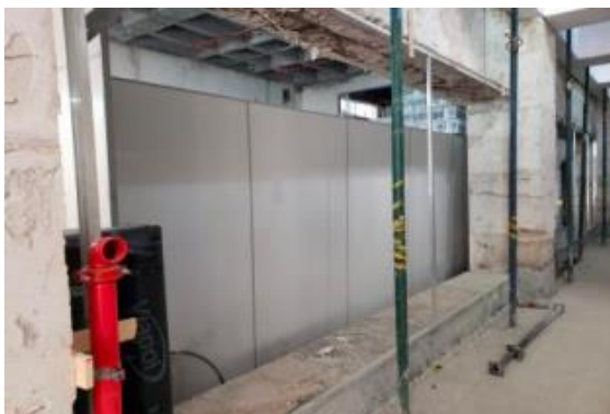
INSTALAÇÃO DE CONTRAMARCOS (TÉRREO)
