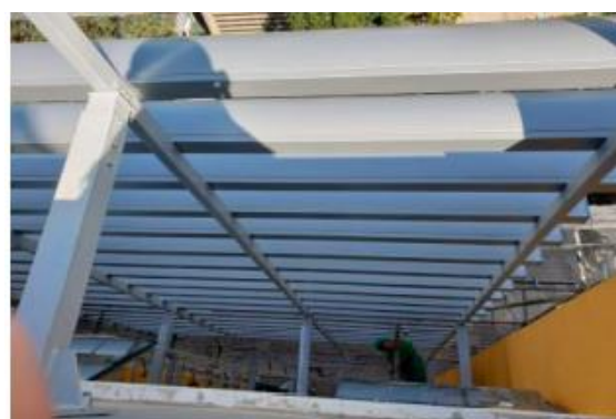
INSTALAÇÃO DOS BRISES
