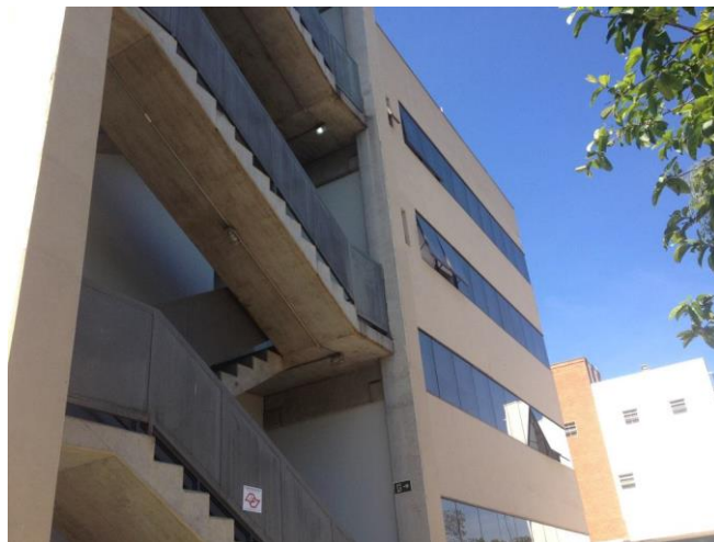
Fachada do Bloco Administrativo 02 – escada de emergência
