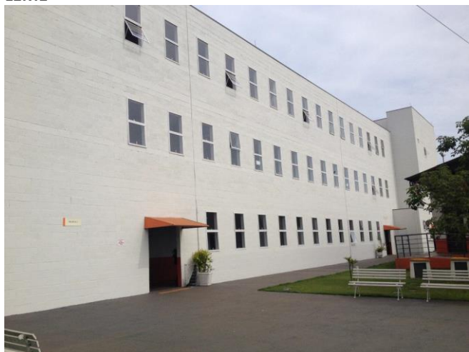
Bloco C – Fachada
