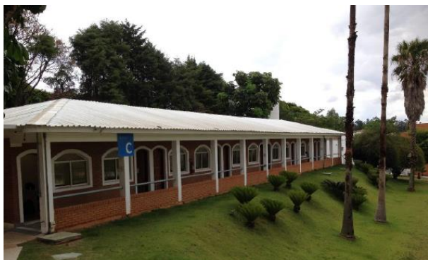
Fachada – Bloco C
