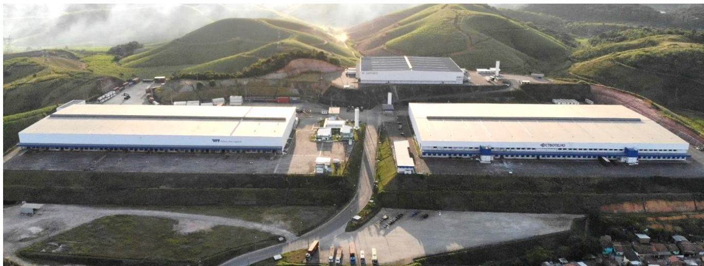
Imagem 1: Foto Aérea do Imóvel
