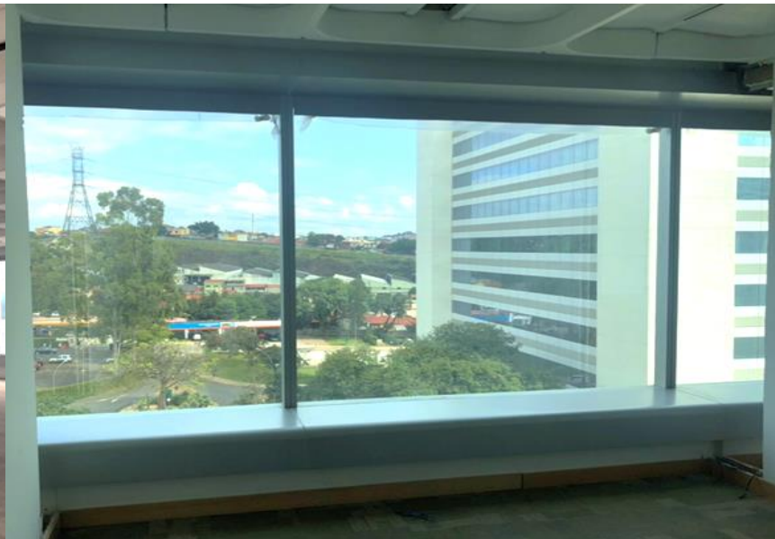
Vista Externa – Andar Tipo
