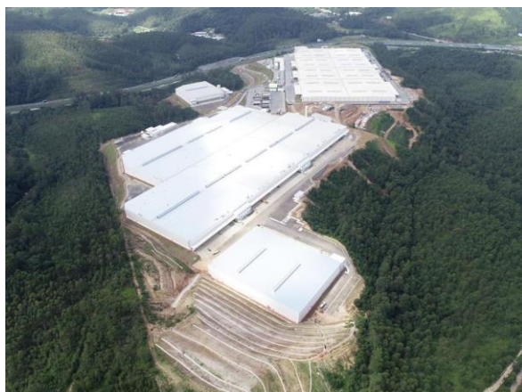
Execução de obras – Foto Panorâmica
