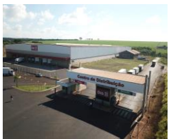
CD Dia% Ribeirão Ribeirão Preto, SP Via José Luiz Galvão, 1.905 Área construída: 21.136 m 2 Participação: 100% Pé-direito (m): 12 Capacidade do Piso (ton/m 2 ): 6
