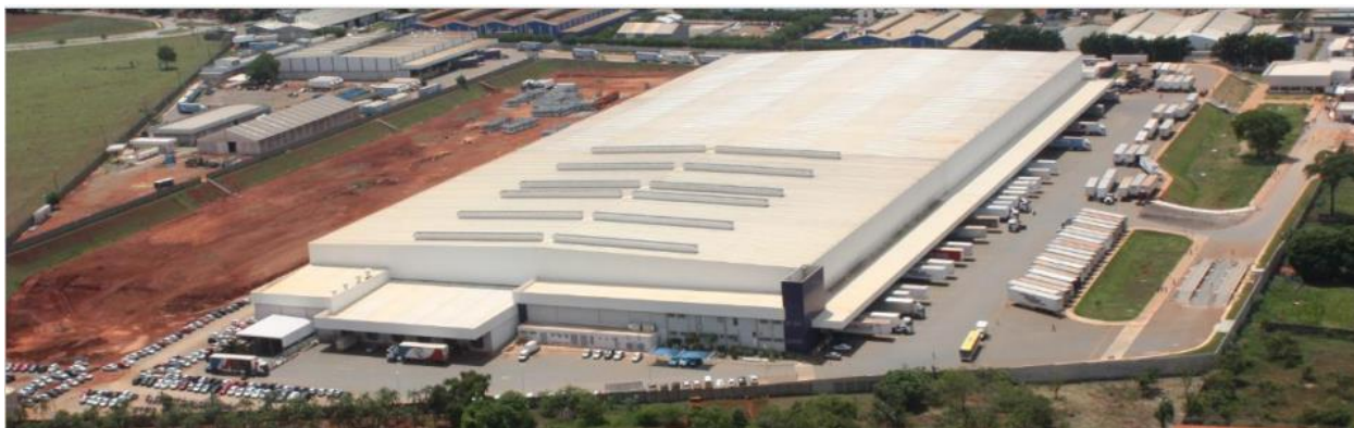
Imagem aérea do Imóvel
