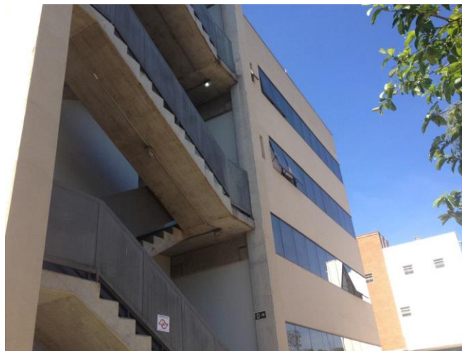
Fachada do Bloco Administrativo 02 – escada de emergência
