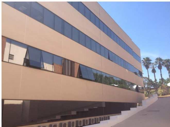
Bloco Administrativo 02 – fachada lateral
