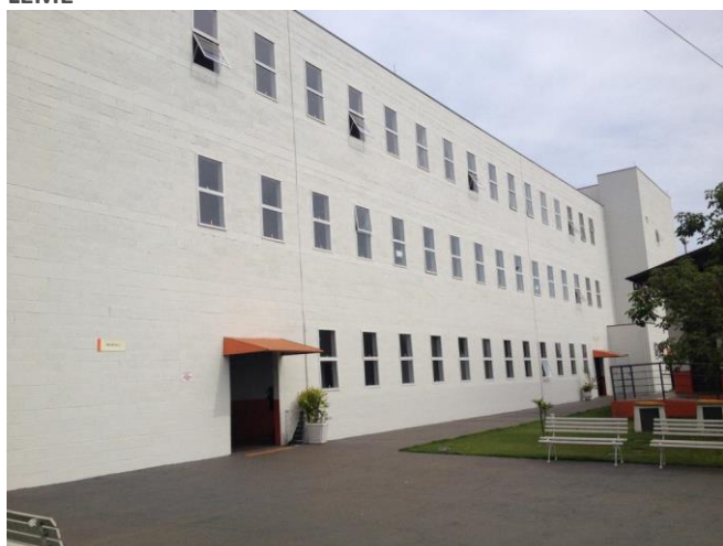
Bloco C – Fachada
