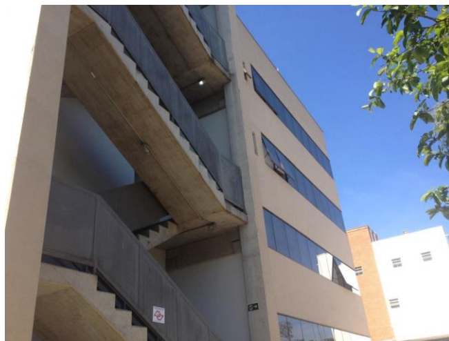
Fachada do Bloco Administrativo 02 – escada de emergência
