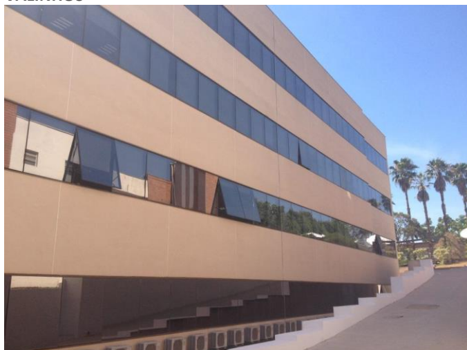
Bloco Administrativo 02 – fachada lateral
