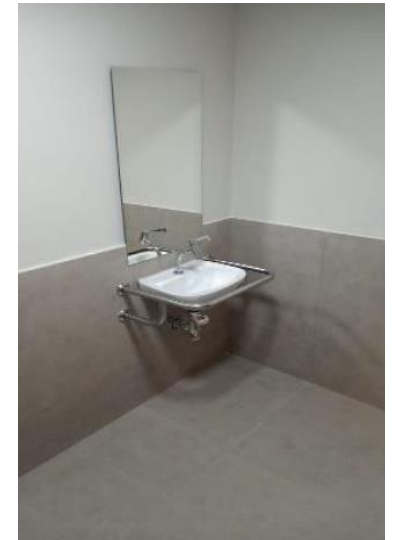
Banheiros PNE do 3 o ao 5 o subsolo
