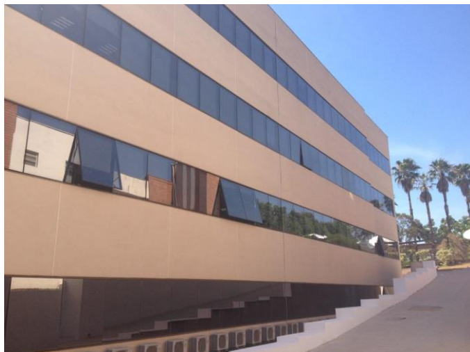
Bloco Administrativo 02 – fachada lateral
