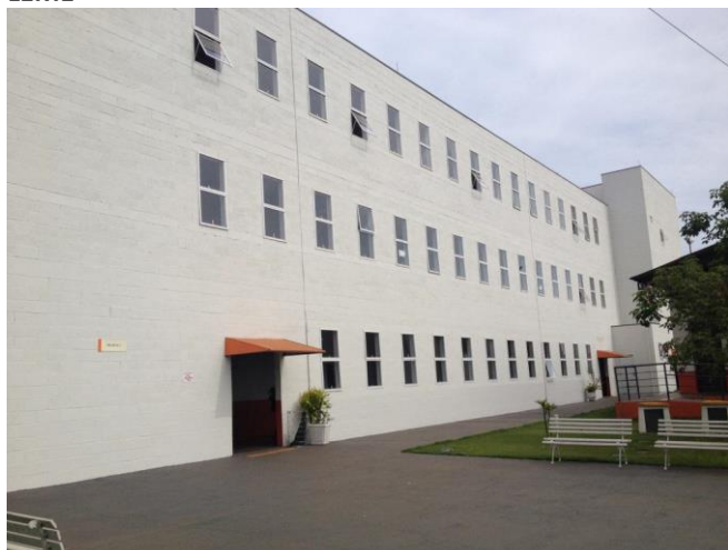
Bloco C – Fachada
