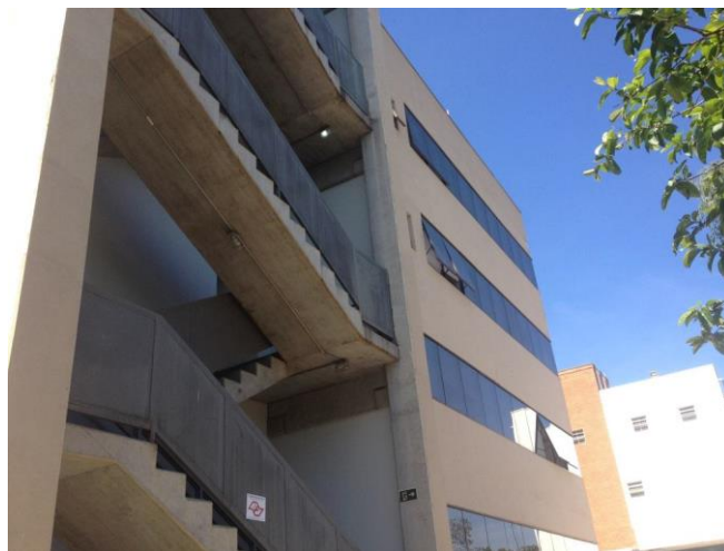
Fachada do Bloco Administrativo 02 – escada de emergência
