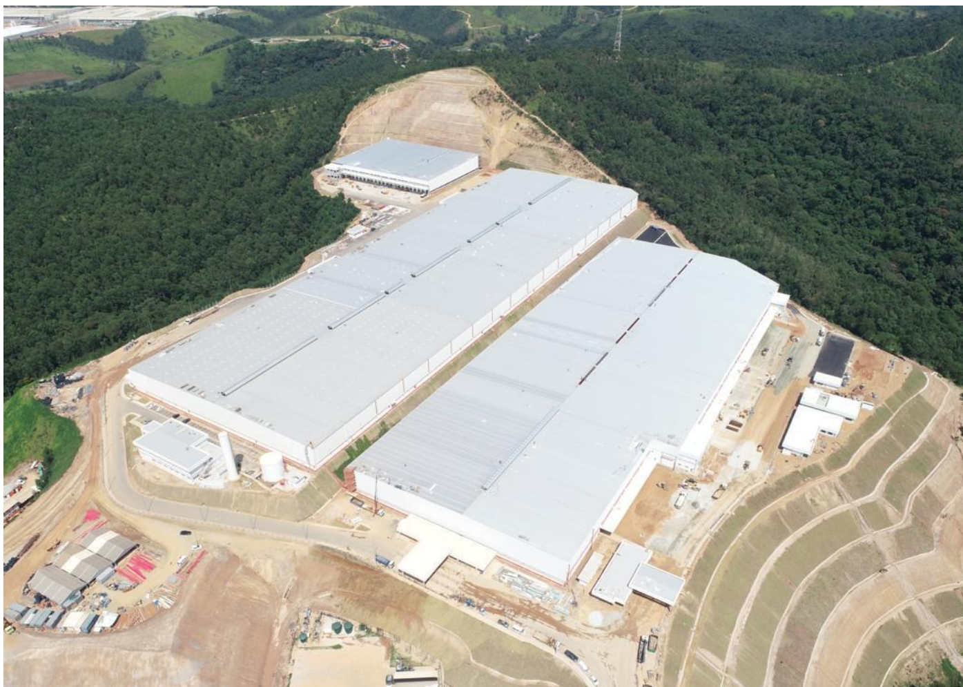
Execução de obras – Foto Panorâmica
