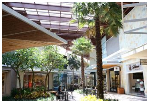
Cobertura da Alameda
