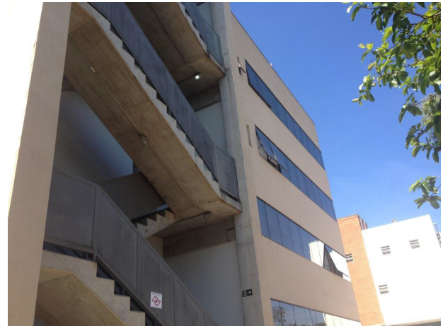
Fachada do Bloco Administrativo 02 – escada de emergência
