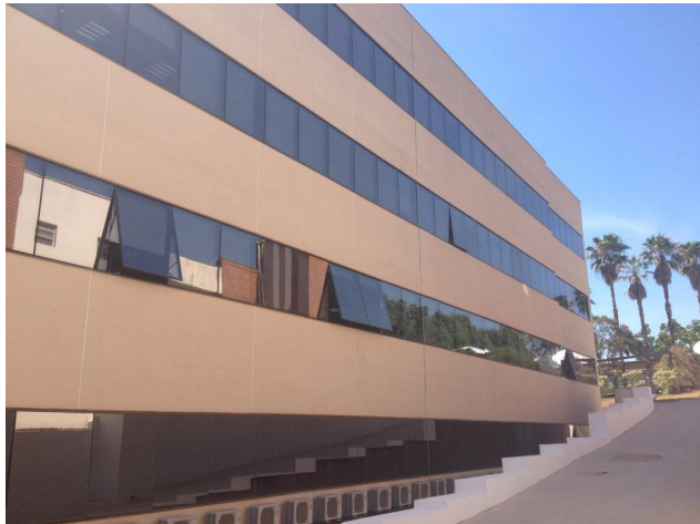
Bloco Administrativo 02 – fachada lateral
