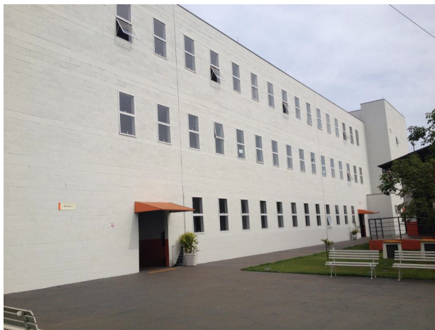
Bloco C – Fachada
