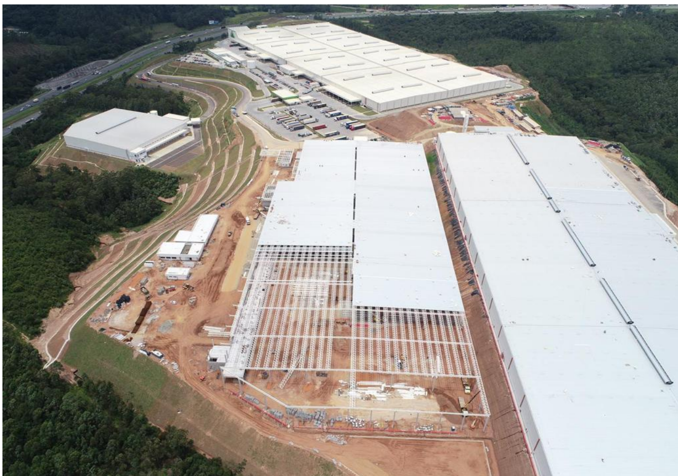
Execução de obras – Foto Panorâmica
