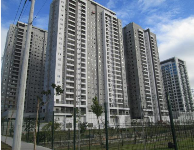
Foto da Obra – Março/17
