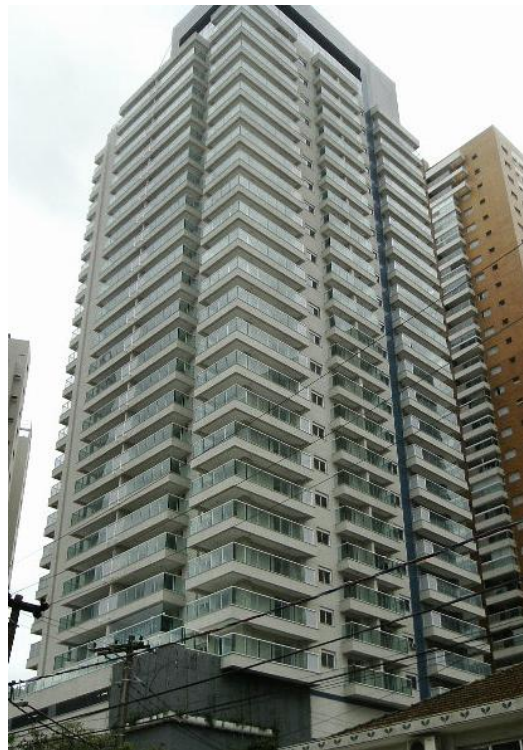
Foto da Obra – Março/17
