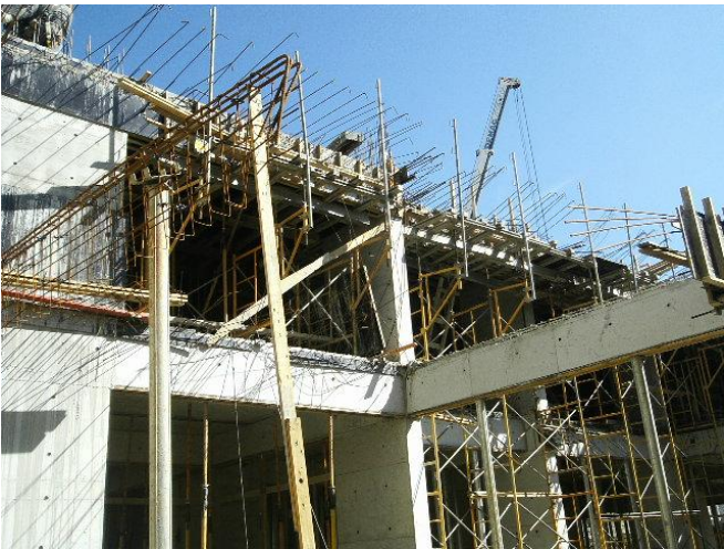
Foto da Obra – Março/17
