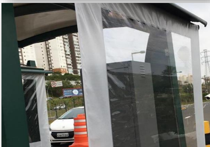
Revitalização de toldos dos gates
