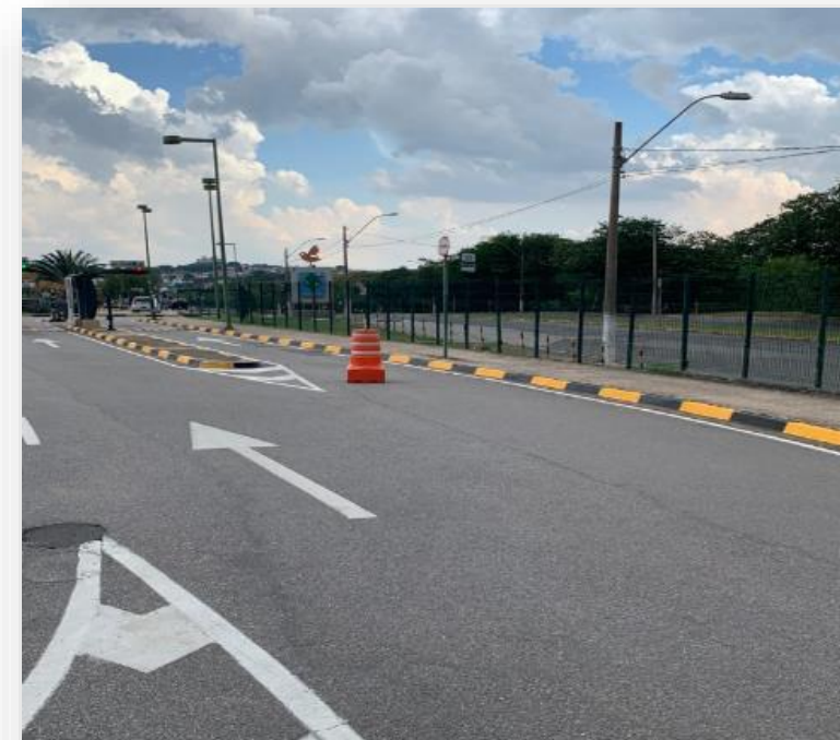
Revitalização e pintura das guias do estacionamento
