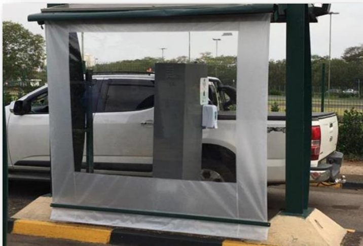
Revitalização de toldos dos gates
