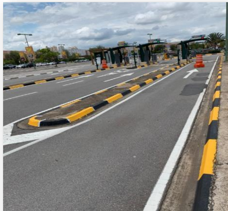
Revitalização e pintura das guias do estacionamento
