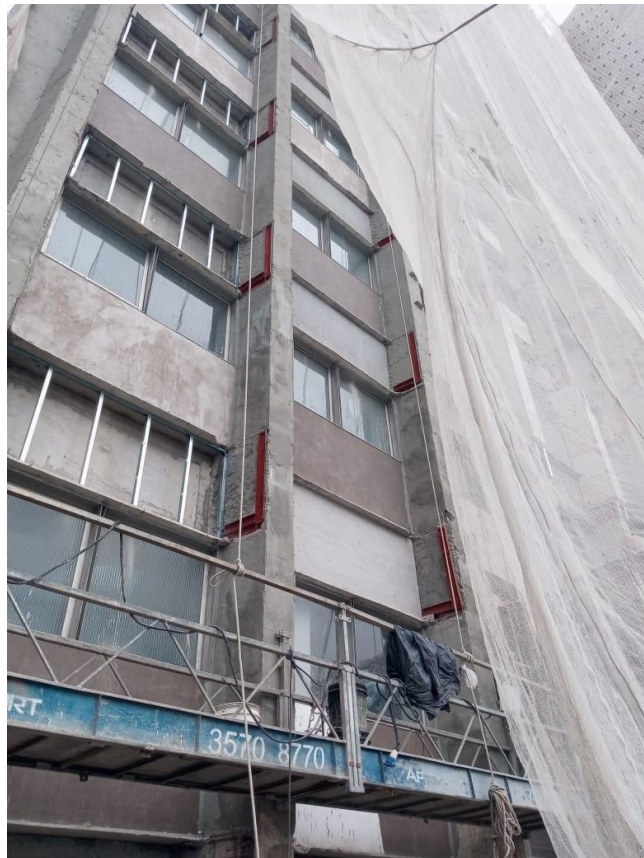
Fachada Carioca – Placas Cimentícias
