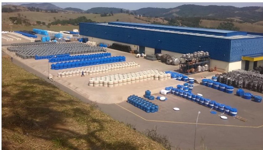
Imagem Imóvel Edifício Acqualimp
