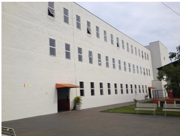
Bloco C – Fachada
