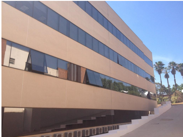
Bloco Administrativo 02 – fachada lateral
