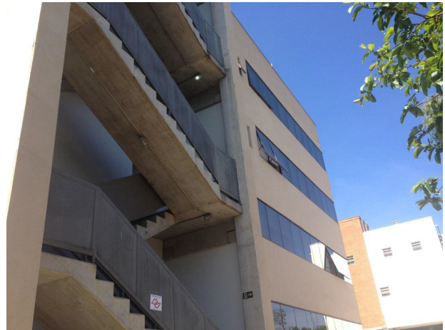
Fachada do Bloco Administrativo 02 – escada de emergência
