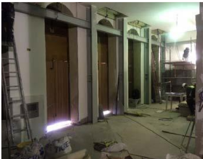
Imóvel - Pátio do Colégio (70% Concluído)
