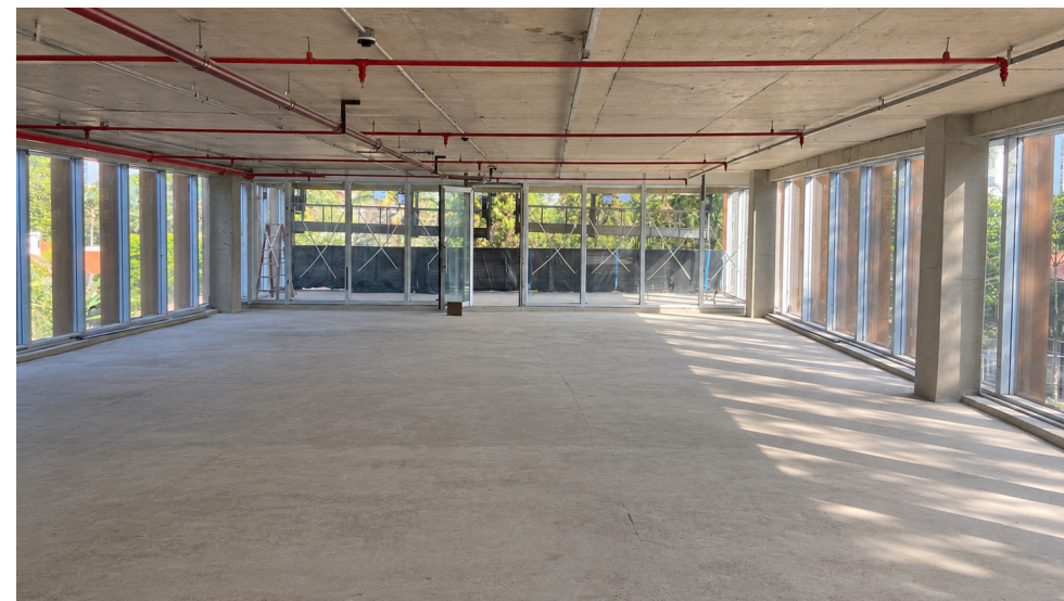
FOTO DA OBRA
