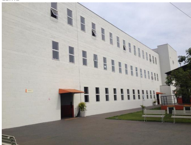
Bloco C – Fachada
