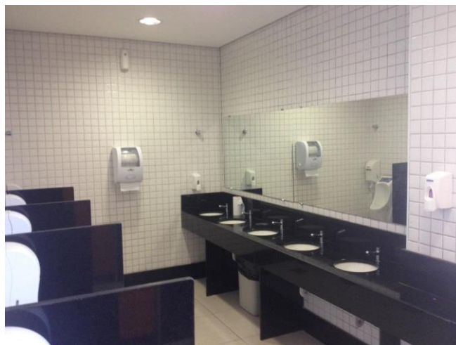
Bloco Administrativo 02 – sanitário
