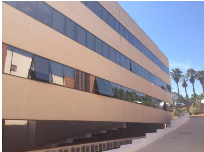
Bloco Administrativo 02 – fachada lateral
