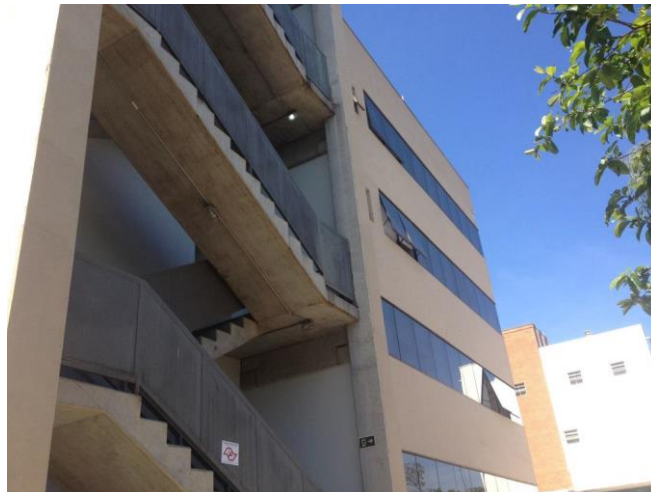
Fachada do Bloco Administrativo 02 – escada de emergência
