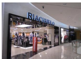
Obras em Junho/15
